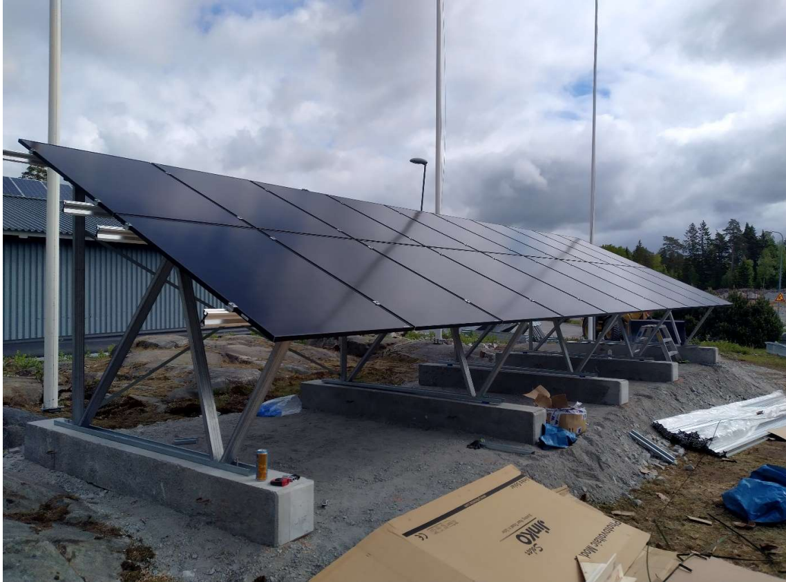
Uusia aurinkopaneleita rakenteilla Lehtiniemen lämpölaitoksen pihalla.
