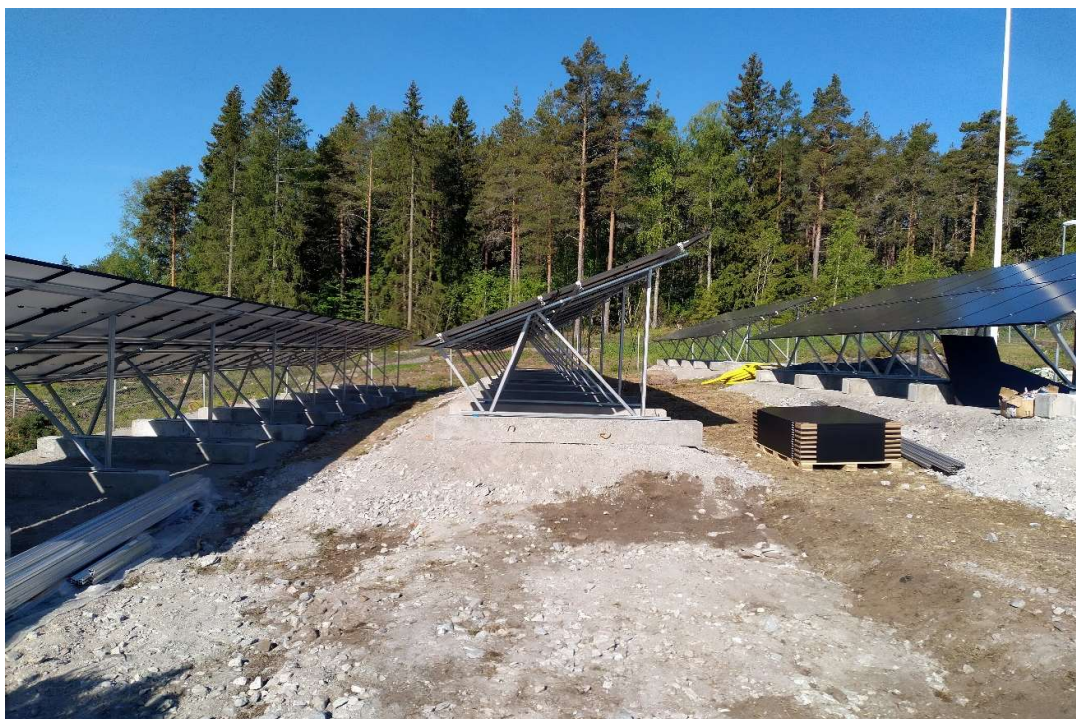
Nya solpaneler installeras under sommaren 2023.
