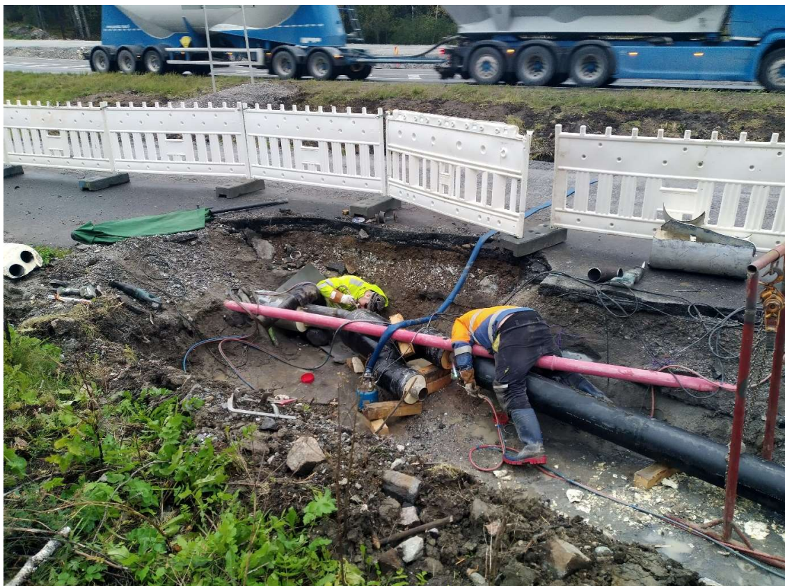
Flytt av fjärrvärmelinje vid nya Hessundsbron hösten 2023.
