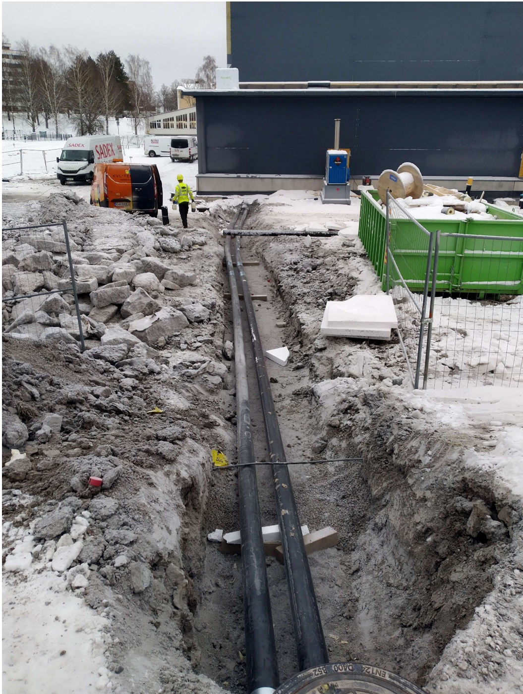
Kaukolämpöliittymä rakenteilla kaupungin uuteen liikuntahalliin syksyllä 2023.
