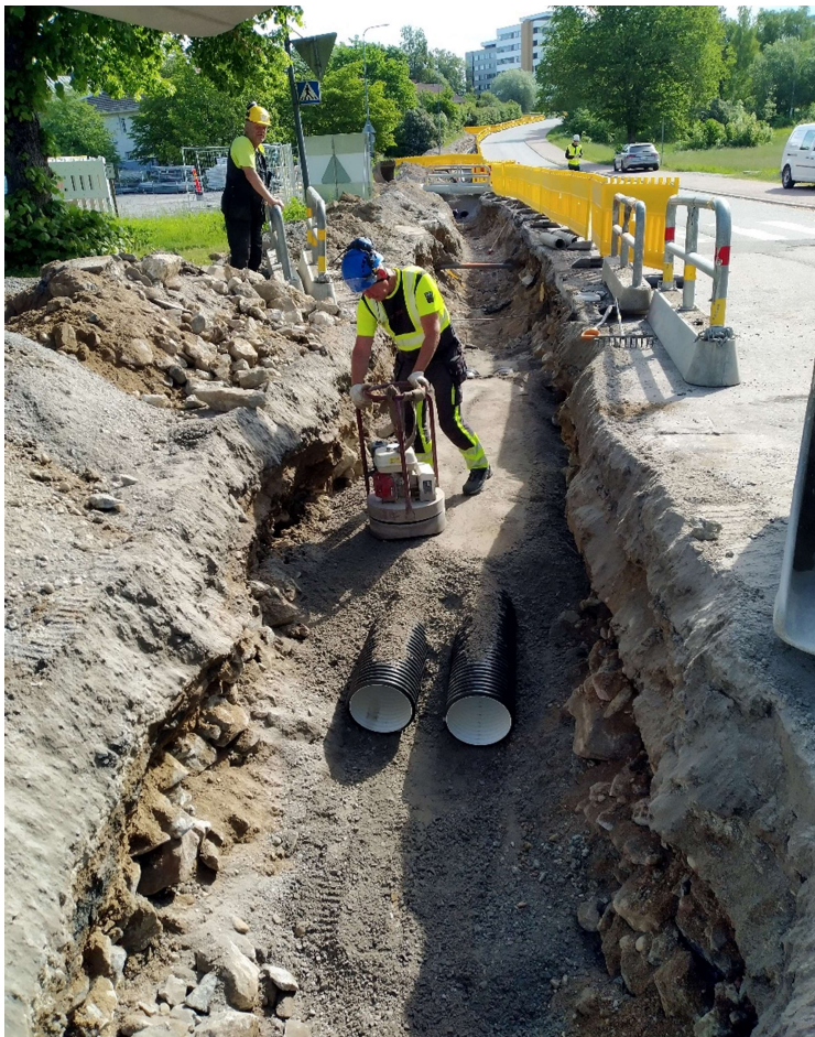
Byggande av nytt fjärrvärmerör vid Parsbyvägen sommaren 2022.
