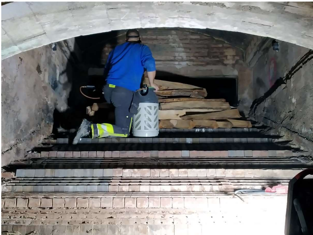
Bio1 hakelaitoksen käynnistys 15.11.2022.
